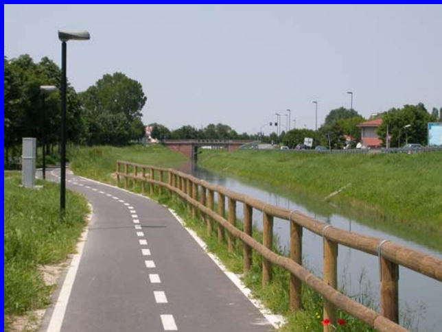
Pista ciclabile Rovigo-Sarzano- LUNGHEZZA COMPLESSIVA 1Km e 400m (completata dal PA017)
